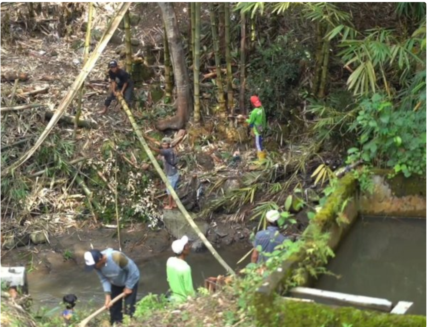
Jembatan Era Kolonial di Desa Kranggan Akhirnya Direvitalisasi, Buka Akses Vital Warga Hingga ke Yogyakarta
